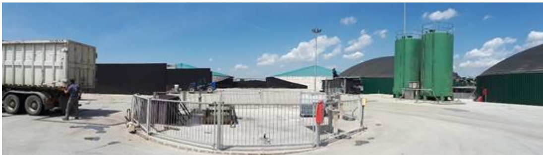
BIOGAS-LAGADA SA – companie premiată în 2017 pentru contribuția la reciclarea deșeurilor prin producerea de biogas
