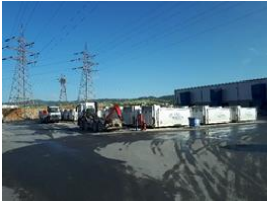
Thessaloniki Waste Transfer Station pentru managementul deșeurilor solide și Environmental park of Derveni
